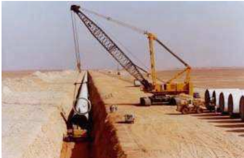
Žeriav s nosnosťou niekoľkých stoviek ton ukladá potrubie do zeme. Zdroj: UNESCO
