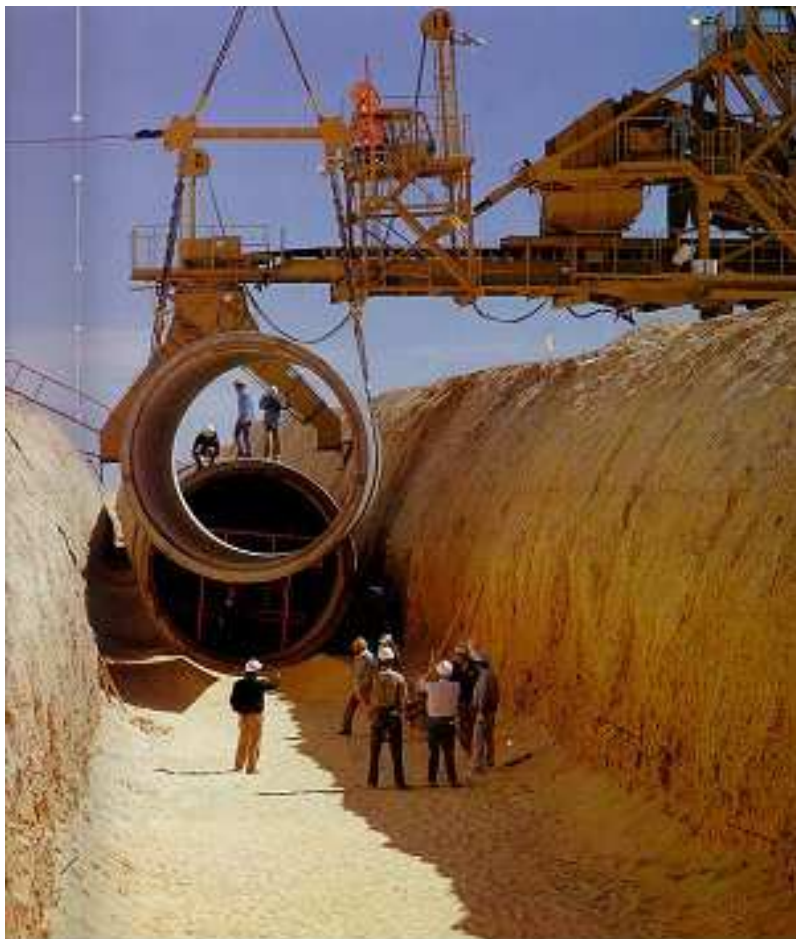
Ukladanie potrubia do vyhlbenej priekopy. Zdroj: 7-Technologies A/S
