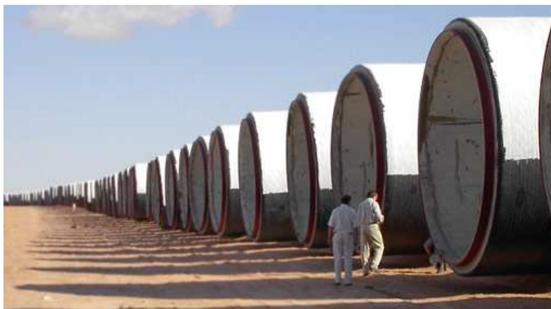
Potrubie pripravené na inštaláciu. Zdroj: Halcrow
