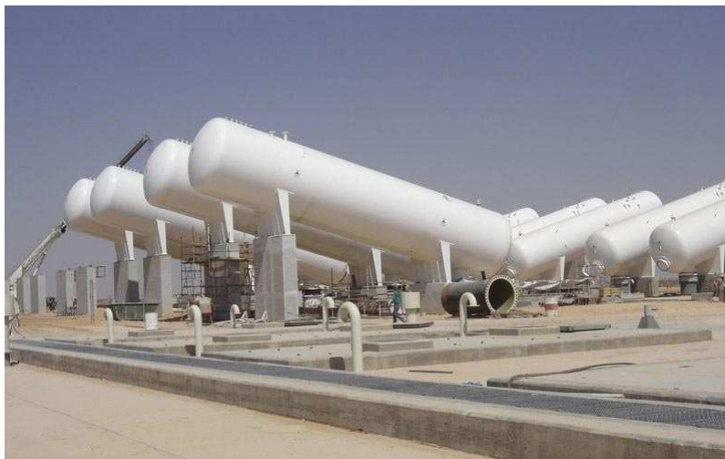
Súčasťou projektu je aj táto sústava vysokotlakových nádob s futuristickým dizajnom. Zdroj: Socomenin company
