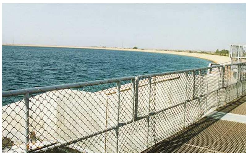
Rezervoár Umar Al-Mukhtar po dokončení. Je najväčším rezervárom vody projektu slúžiacim na zabezpečenie kontinuálnej dodávky vody počas celého roka. Zdroj: Galen Frysinger
